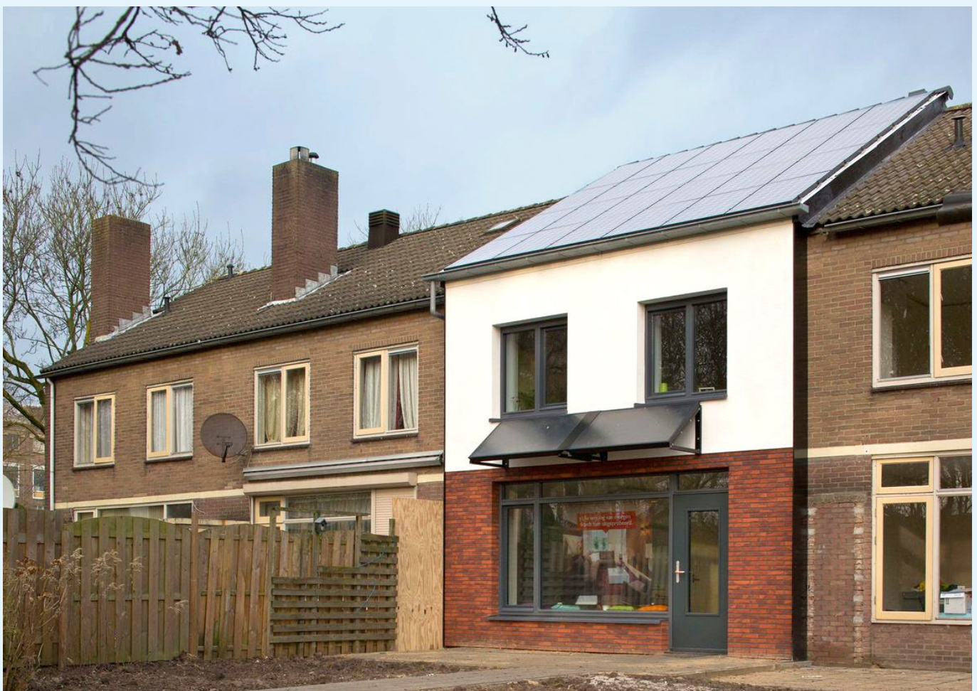
Abbildung 2: Seriell saniertes Reihenhaus
